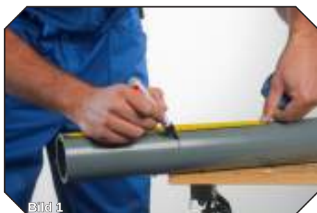
Markera röret med en markeringspenna
