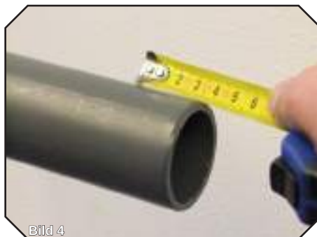
Markera insticksdjupet på röret
