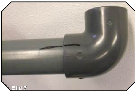
Markera rätt monteringsposition
