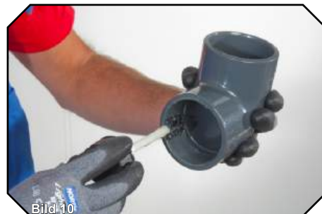
Applicera ett tunt lager lim i en cirkulär rörelse (4-6x) runt hela rördelens insida. *
