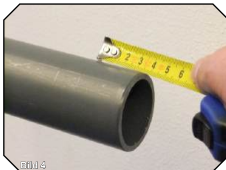
Markera insticksdjupet på röret
