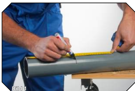
Markera röret med en markeringspenna
