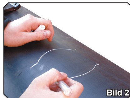
Bild 1. Markera med markeringspenna (se sidan 126) var du ska montera toploadingsadeln.
