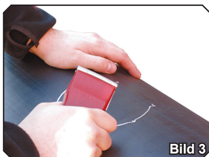
Bild 3. Du ska nu skrapa bort oxidskiktet (0,2mm) med exempelvis en handskrapa eller svarv (se sidan 126). Oxidskiktets tjocklek varierar och beror på ålder, samt lagring av röret. Den markerade ytan + 1 cm utanför markerat område ska skrapas.
