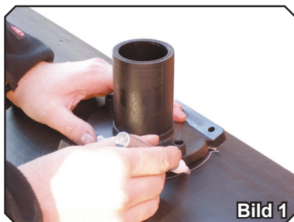
Bild 1. Markera med markeringspenna (se sidan 126) var du ska montera toploadingsadeln.
