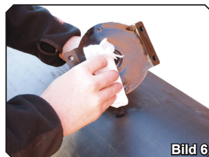
Bild 5. Du ska nu rengöra röret med en rengöringssprit som överstiger 96% (se sidan 128). Viktigt är att du inte vidrör ytan med händerna efter rengöringen. (Fettfritt)
