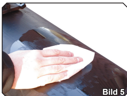
Bild 5. Du ska nu rengöra röret med en rengöringssprit som överstiger 96% (se sidan 128). Viktigt är att du inte vidrör ytan med händerna efter rengöringen. (Fettfritt)
